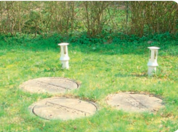
Abdeckungen und Belüftung einer Kleinkläranlage
